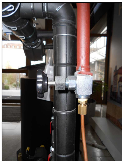
Abb. 3: Nadeldrosselventil
